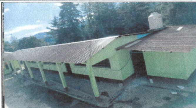
Foto 2: Sustitución de Capote para lamina troquelada
