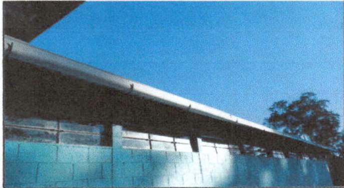
Foto 7: sustitución de canal de pvc
