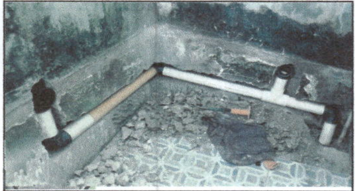
Foto 10: sustitución de mingitorios
