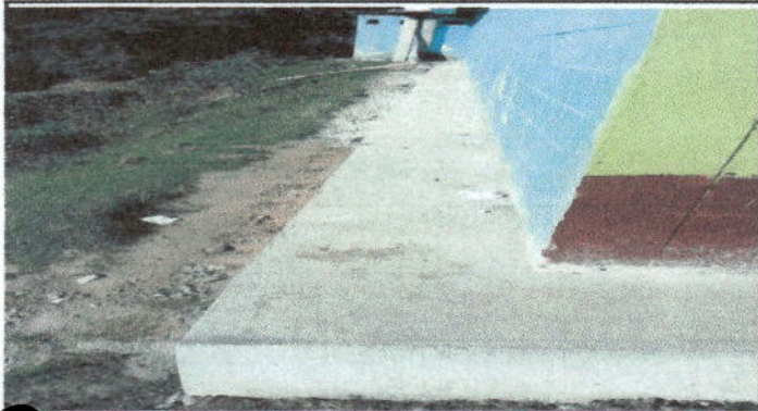
Foto 13: Reparación de plancha de concreto en banqueta de aulas de 3ro, 4to y 6to.
