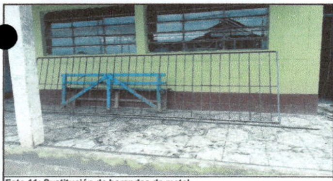
Foto 11: Sustitución de barandas de metal
