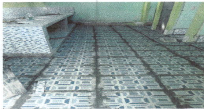
Foto 6: sustitucion de piso de cemento por ceramico antideslizante
