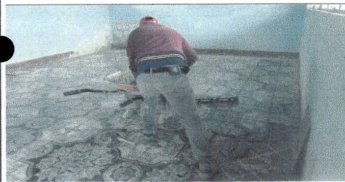
Foto 5: sustitución de piso de cemento líquido por ceramico
