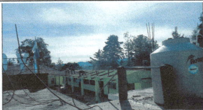
Foto1: sustitución de lámina por lámina troquelada colarum C 26
