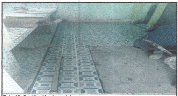
Foto 12: Sustitución de azulejo
