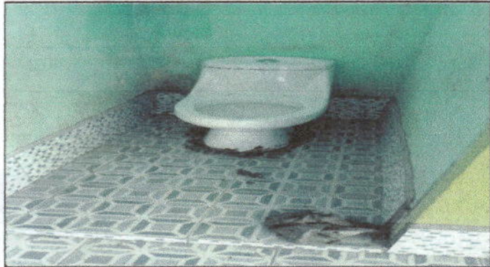
Foto 9: sustitución de accesorios para inodoro inodoro
