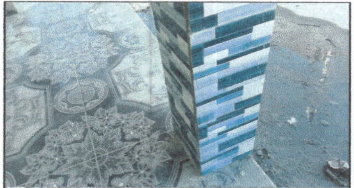
Foto 16: Repello en muro y columna de corredor de las aulas de 3ro,4to y 6to.
